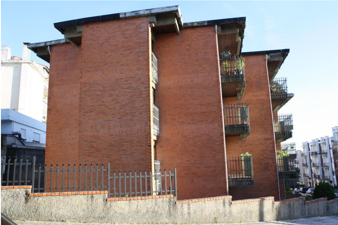
Fig. 37 – Vista do alçado lateral esquerdo, do mesmo edifício.
