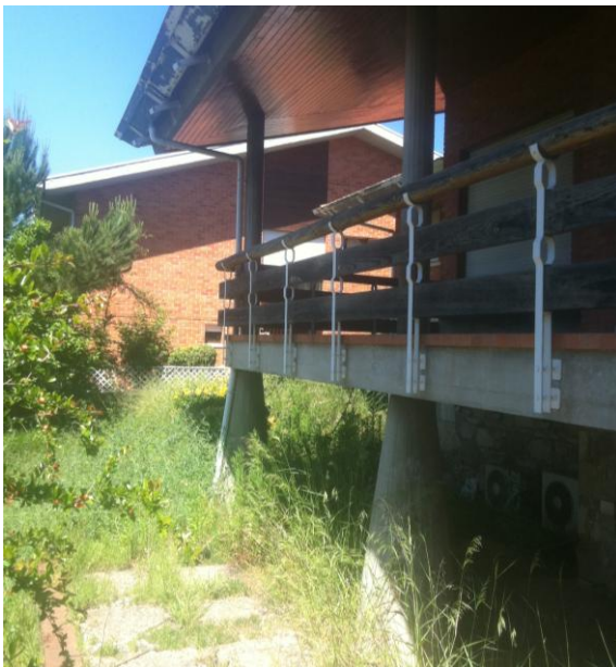
Fig. 76 – Pormenor da varanda, apoiada em pilares cónicos até à laje, com guardas em estrutura de ferro e elementos de madeira.
