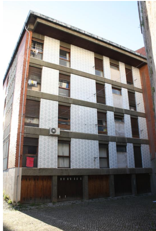
Fig. 39 – Vista do lado sudeste, da fachada posterior.
