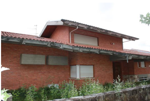
Fig. 63 – Frente da residência de Vasco Cunha, vista do lado nascente.
