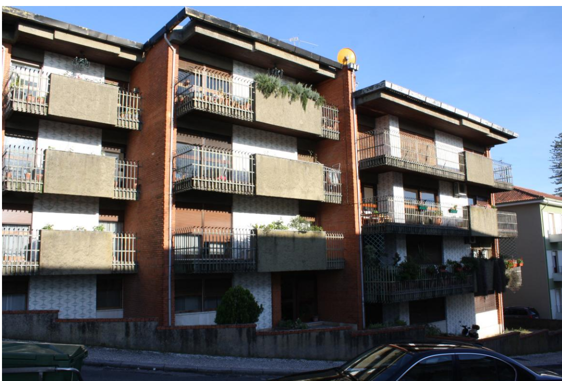
Fig. 36 – Vista do alçado principal, do edifício plurifamiliar, construído para António Campos Bento Rodrigues, na Rua Sá de Miranda em Coimbra.
