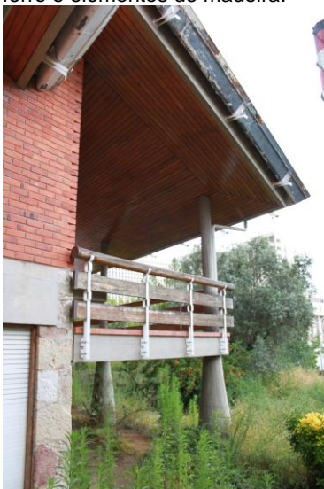
Fig. 78 – Vista da varanda, vista do lado poente.
