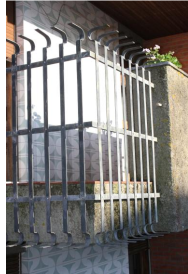
Fig. 46 – Pormenor das varandas.
