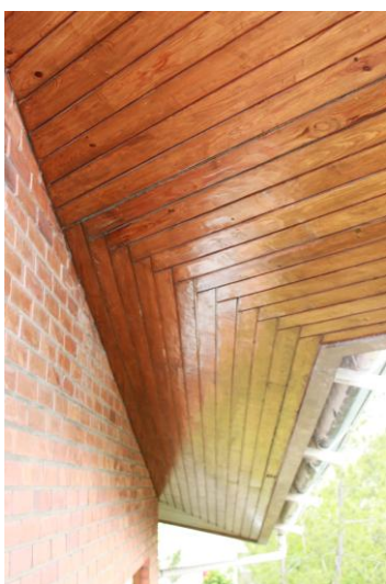
Fig. 83 – Detalhe do forro do avançado da cobertura
