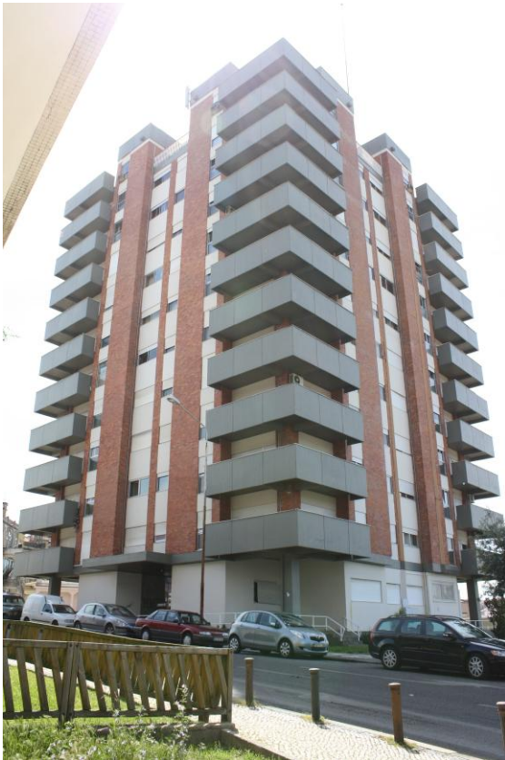
Fig. 52 – Vista do edifício Panorama do lado norte, da Rua de Aveiro, por onde é feita a entrada.
