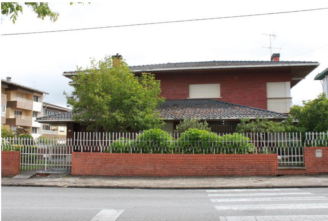
Fig. 16 – Vista actual da frente da casa promovida para António Pereira Lucas Martins.
