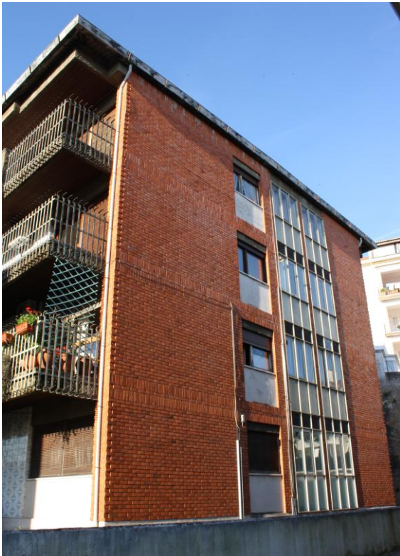
Fig. 38 – Vista do alçado lateral direito do edifício plurifamiliar.
