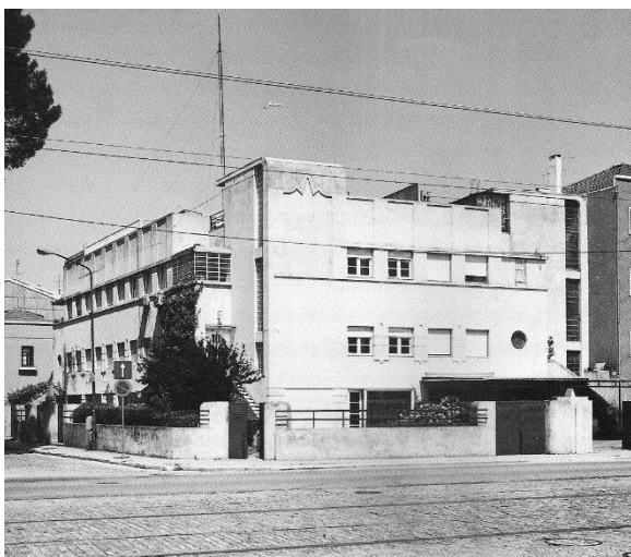
Fig. 2 – Edifício da Rua de Pinheiro Manso, Porto, 1936. Fonte: Câmara Municipal de Matosinhos, 1995, p.15
