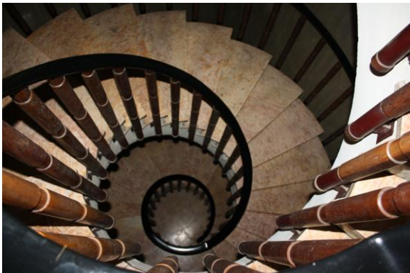
Figs. 60 e 61 – Vista superior e inferior da escada helicoidal que relaciona, verticalmente, todos os níveis do edifício Panorama.
