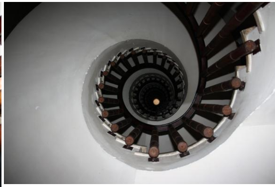
Figs. 60 e 61 – Vista superior e inferior da escada helicoidal que relaciona, verticalmente, todos os níveis do edifício Panorama.
