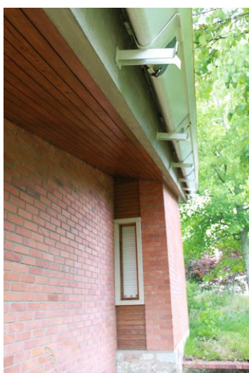
Fig. 84 – Soco em pedra, alvenaria de tijolo à vista, madeira no forro da cobertura e no paramento do vão. Peças em ferro, fixadas à estrutura, de sustentação da calceira.
