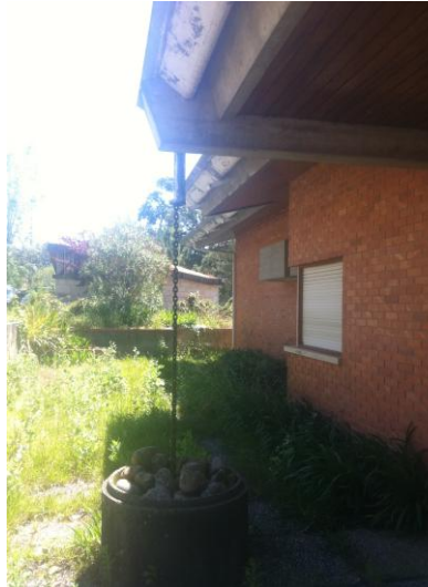
Fig. 68 – Detalhe da recolha das águas pluviais num anel de manilha de betão, preenchido com seixo rolado, sendo o encaminhamento realizado, desde a caleira, por uma corrente de ferro.
