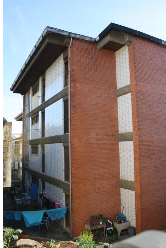
Fig. 41 – Vista do lado noroeste, da fachada posterior.
