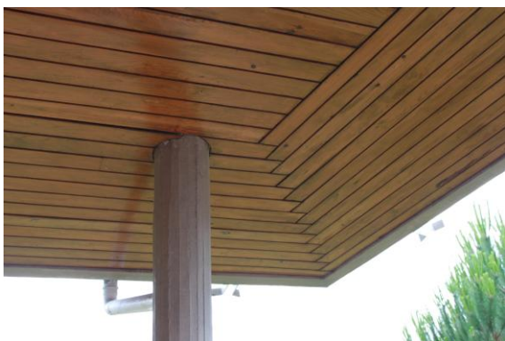
Fig. 81 – Detalhe do remate do forro da cobertura, na varanda
