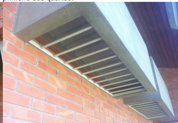
Fig. 73 – Pormenor da face inferior dos volumes salientes da fachada, por onde é feita a iluminação dos sanitários, situados no lado norte.
