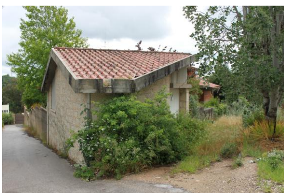
Fig. 86 – Anexo da garagem, construído, posteriormente, no vértice nascente da propriedade, em alvenaria de pedra calcária e cobertura em betão armado.
