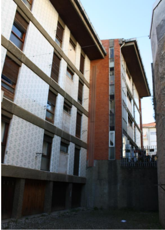
Fig. 40 – Vista da fachada posterior, do edifício plurifamiliar.
