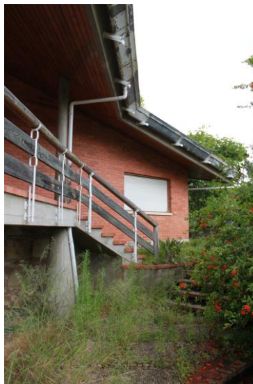
Fig. 79 – Vista da extremidade nascente da fachada posterior.
