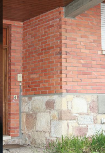
Fig. 69 – Zona da entrada. Vários dos materiais que caracterizam o exterior: soco de pedra calcária, tijolo maciço, madeira nos vãos e forro exterior dos tectos, elementos estruturais em betão e estores em PVC branco.
