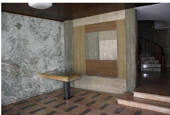
Fig. 54 – Vista do átrio da entrada, com a mesa do porteiro, em pedra, e painel em betão colorido.
