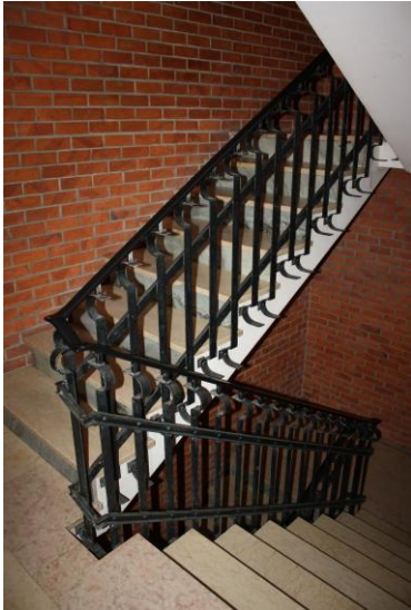
Fig. 44 – Vista da escada interior.
