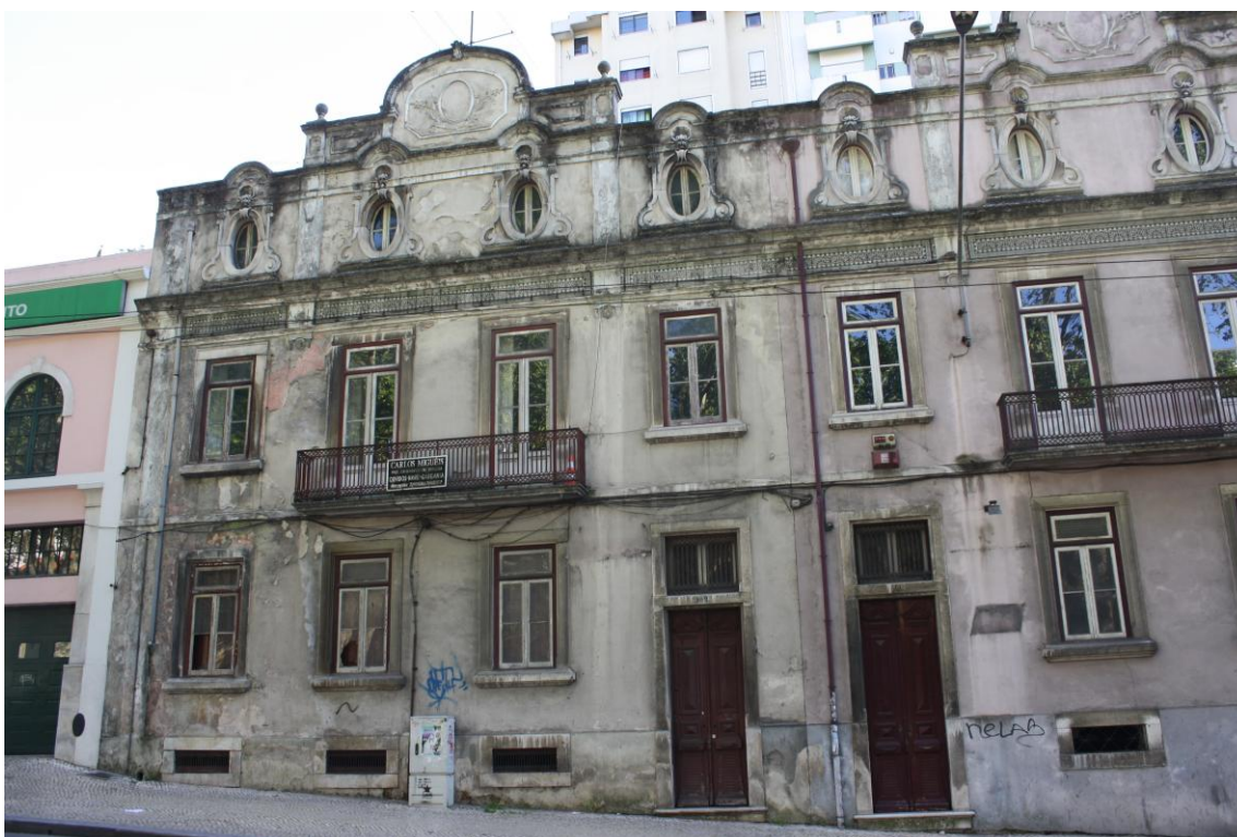
Fig. 14 – Vista do n.º 102, da Avenida Sá da Bandeira, em Coimbra.
