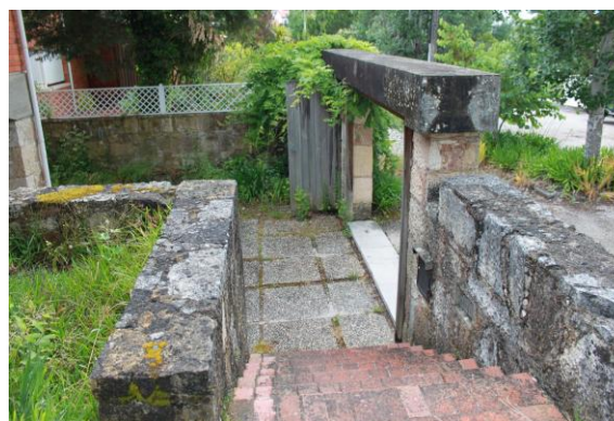
Fig. 66 – Vista, do nível da entrada na habitação, do portão de acesso.
