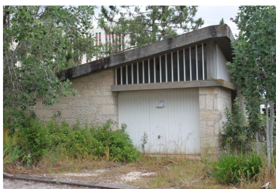
Fig. 87 – Detalhe da entrada do anexo destinado a garagem.
